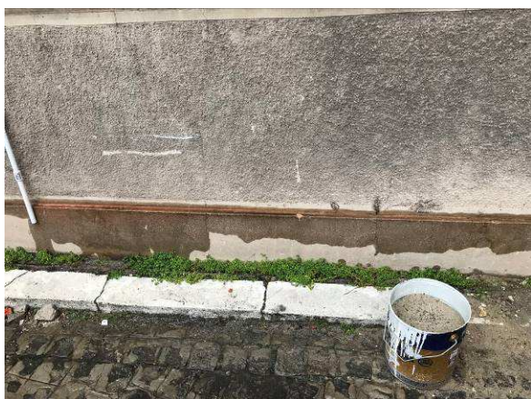
Miejsce lokalizacji projektowanego szybu windowego – widoczne uszkodzenia tynków zewnątrznych | 7
