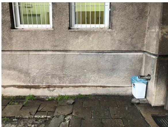
Miejsce lokalizacji projektowanego szybu windowego – widoczne uszkodzenia tynków zewnątrznych | 5
