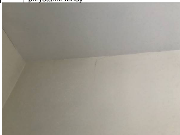
Rysa i pęknięcie na styku ściana murowana – obudowa z płyt G-K
