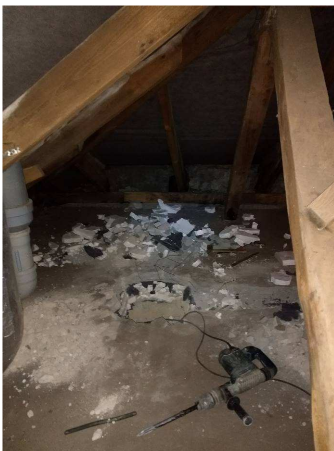
Odkrywka stropu na poddaszu – usunięta warstwa termoizolacji
