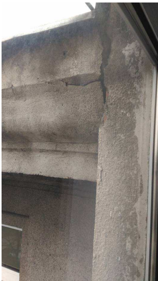
Gzyms – widoczna rysa
