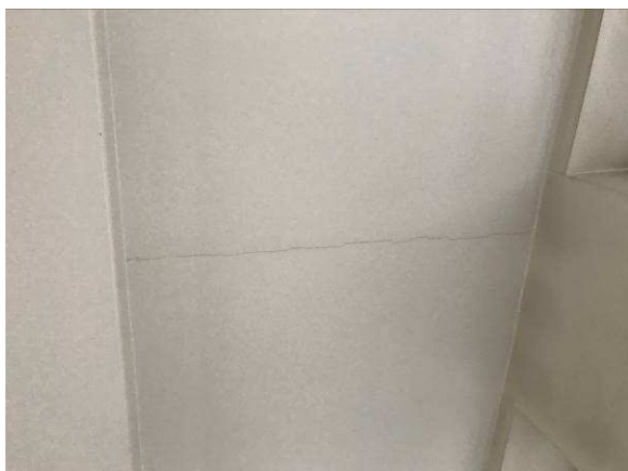
Pęknięcia na styku płyta G-K - sufit
