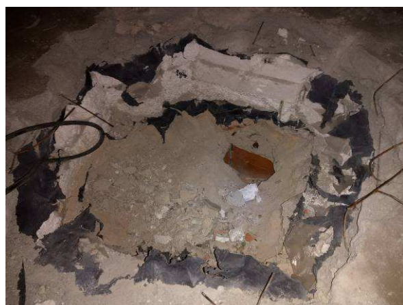
Odkrywka stropu na poddaszu – usunięta warstwa termoizolacji
