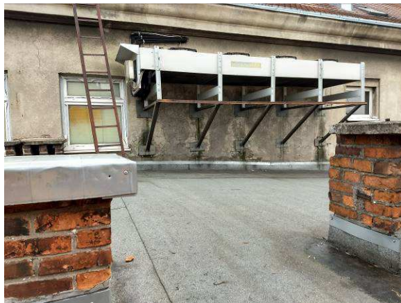
16 | Centrala wentylacyjna mocowana na podkonstrukcji do ściany, obróbka kominów
