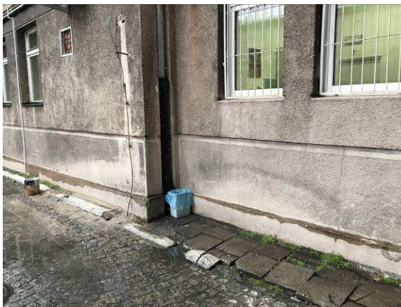
6 | Miejsce lokalizacji projektowanego szybu windowego – widoczne uszkodzenia tynków zewnątrznych
