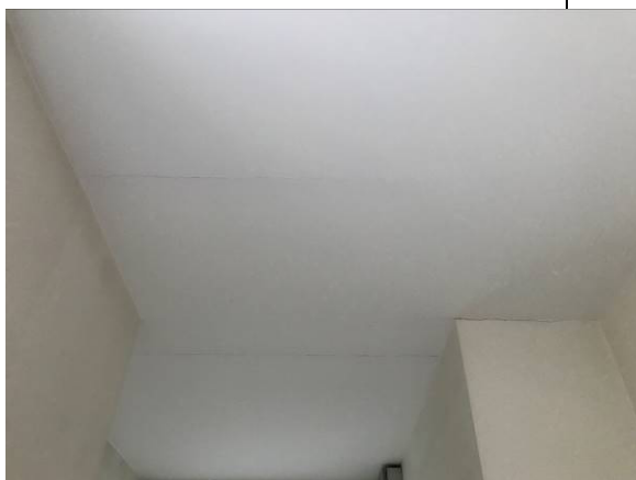
Pęknięcia na styku płyta G-K
