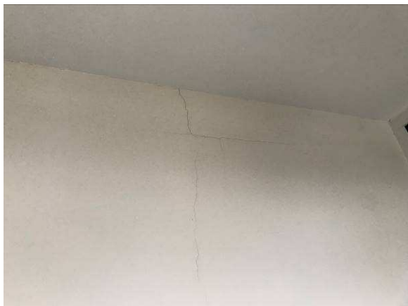
Rysa i pęknięcie na ścianie murowanej klatki schodowej
